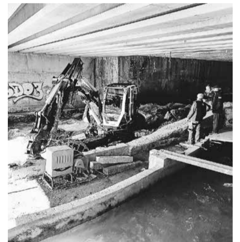
Opruim- en reparatiewerkzaamheden na de vernielingen afgelopen juni.
