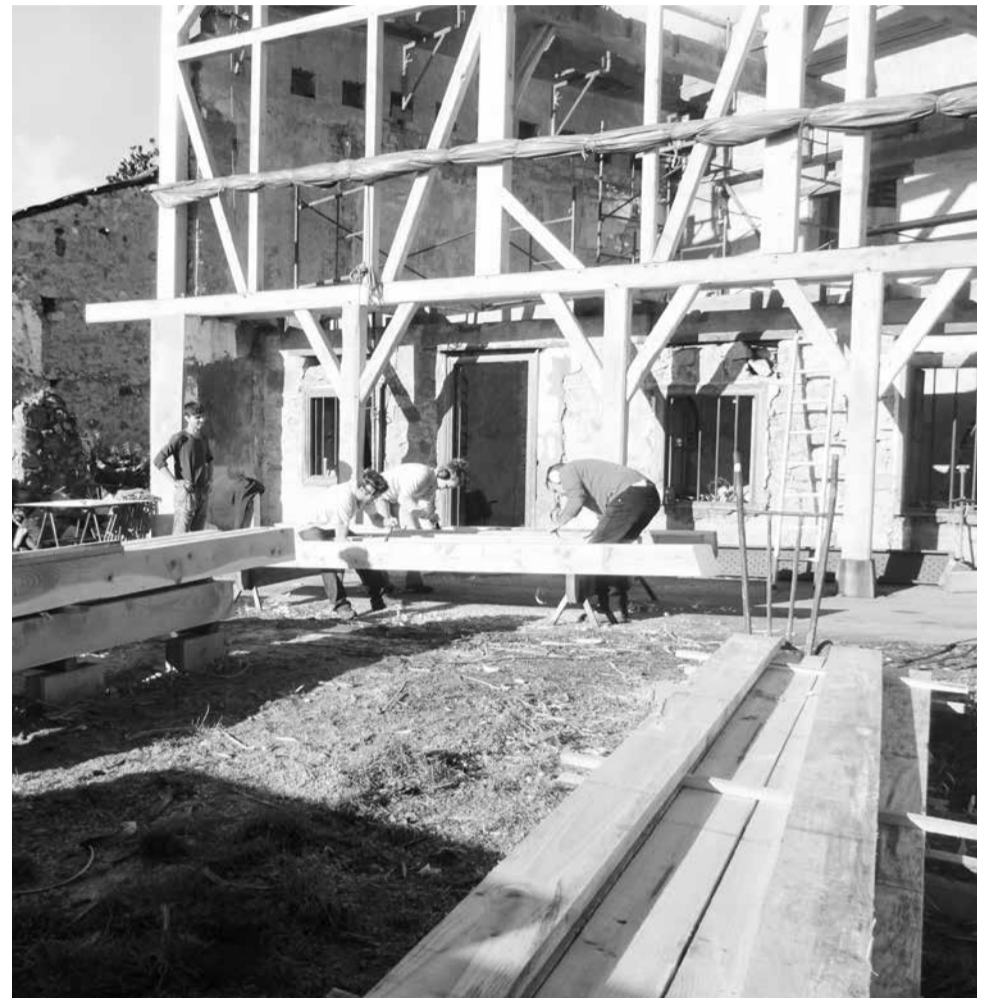
Bij onze dakstoelen gebruiken we praktisch geen ijzerwaar. We werken liever met gat-penverbindingen en haaklassen.
