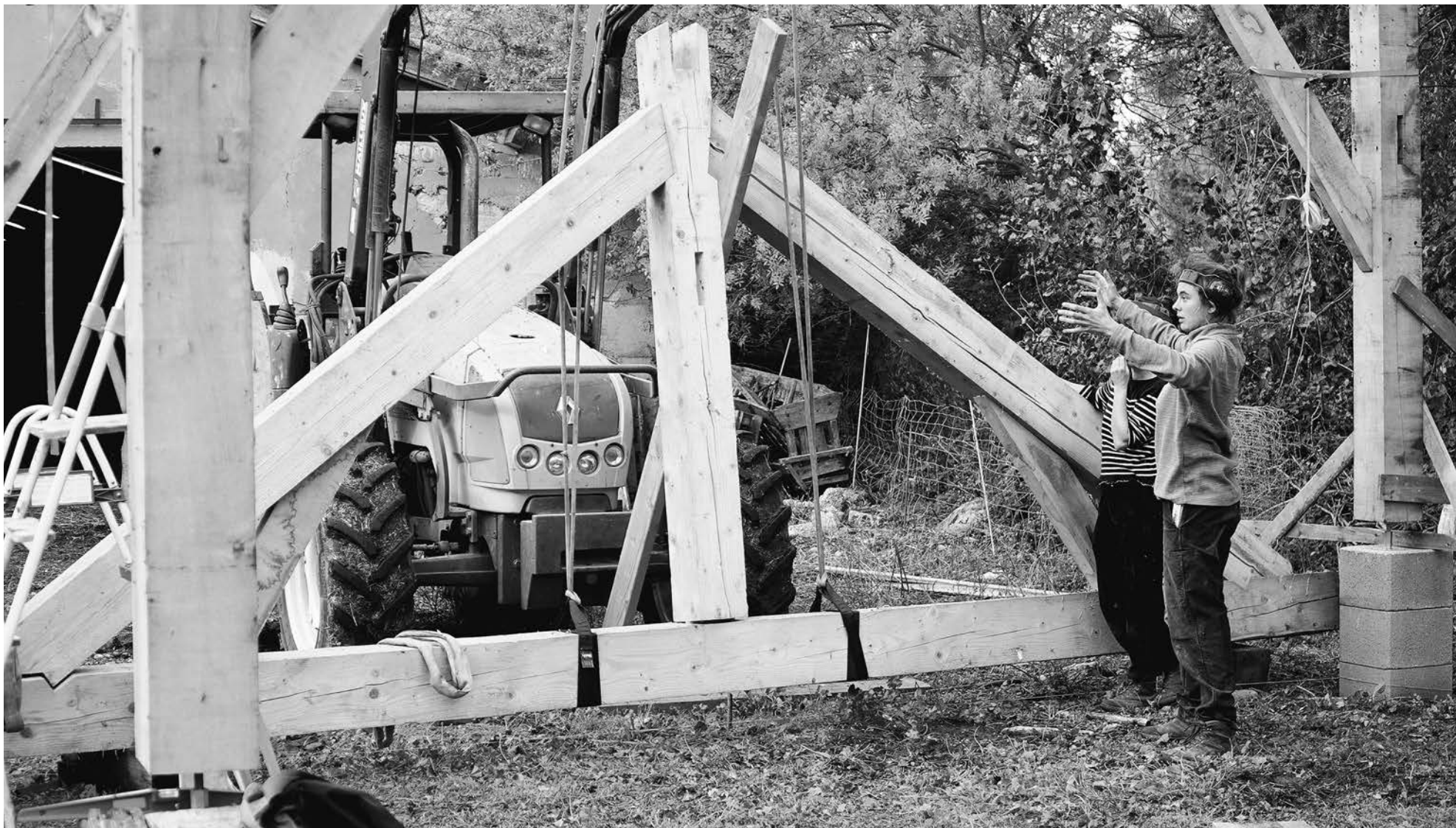
De nodige werkzaamheden voor de nieuwe hangar op de Mas de Granier worden samen uitgevoerd.
