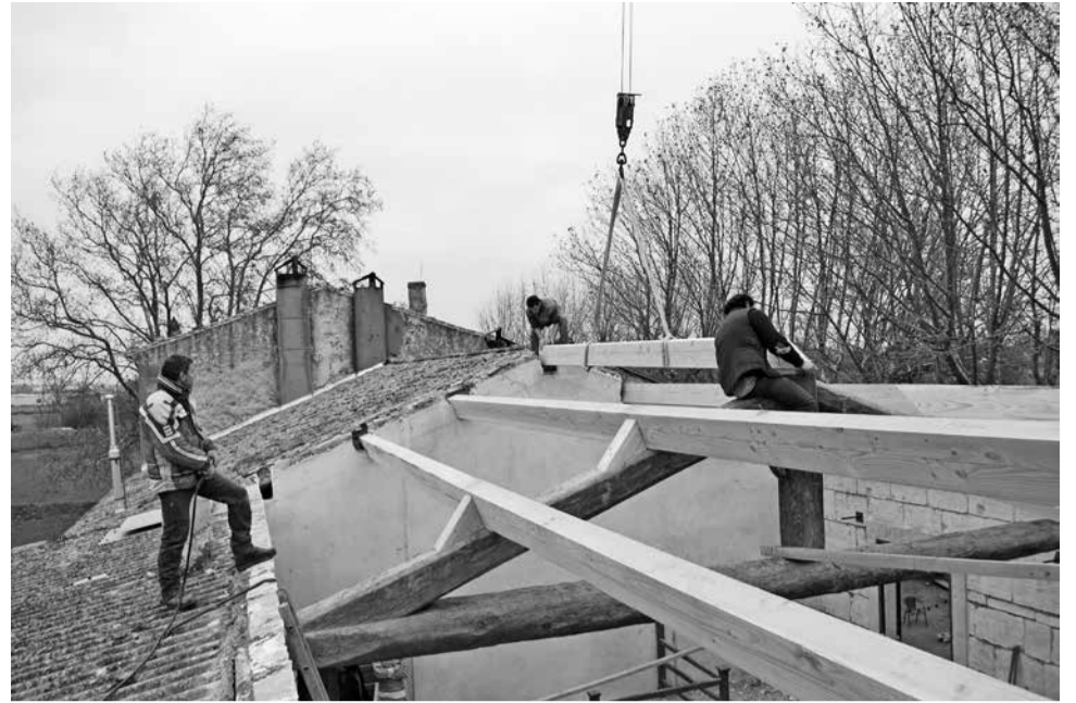
De grote balken worden met de hijskraan opgetakeld.
