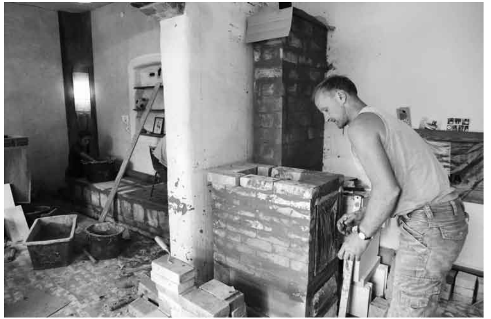
Bouw van een leemkachel in het oude woonhuis op de Ulenkrug
